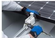
試作品を用いて施工性評価を行います。
